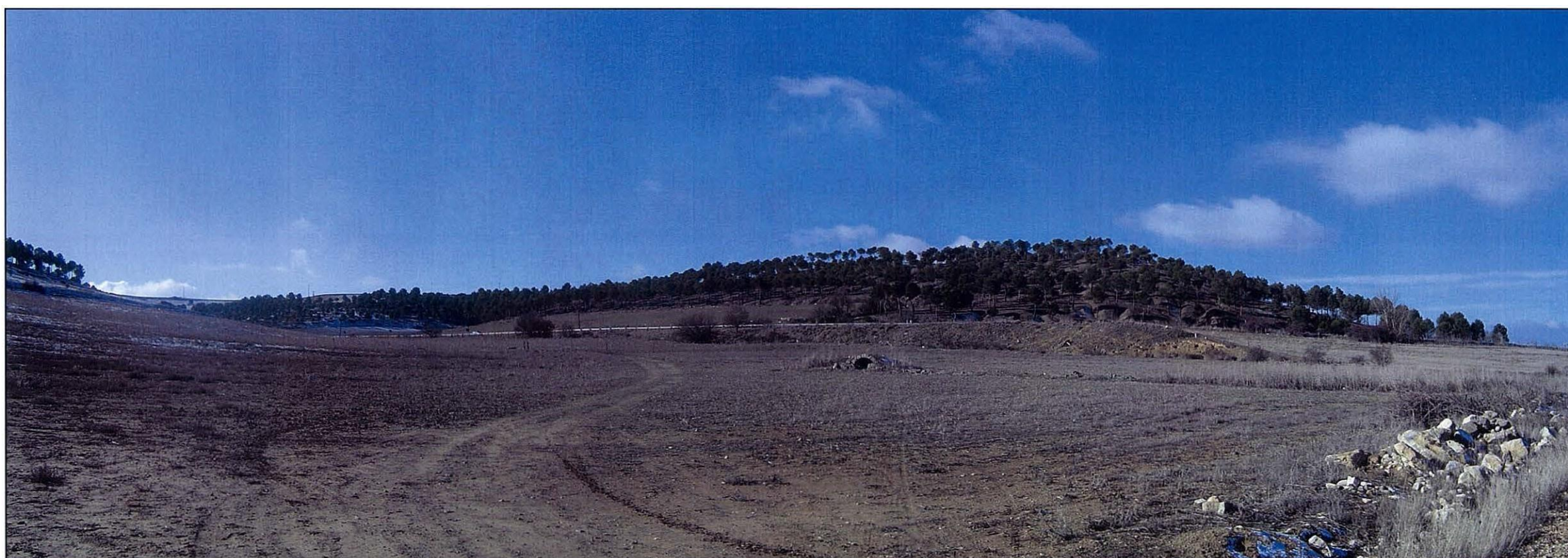
Imagen 2. Vista de las cuestas de los Montes Torozos desde el lugar de paso de la carretera N-601, cuya plataforma se distingue en el centro de la imagen.
