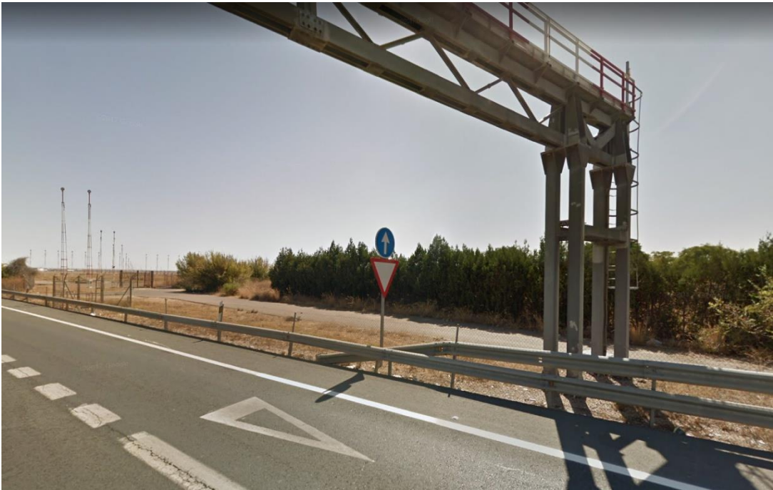
Al fondo visual de zona de actuaciones Eje 38. Se observa la puerta de salida emergencias del aeropuerto.
