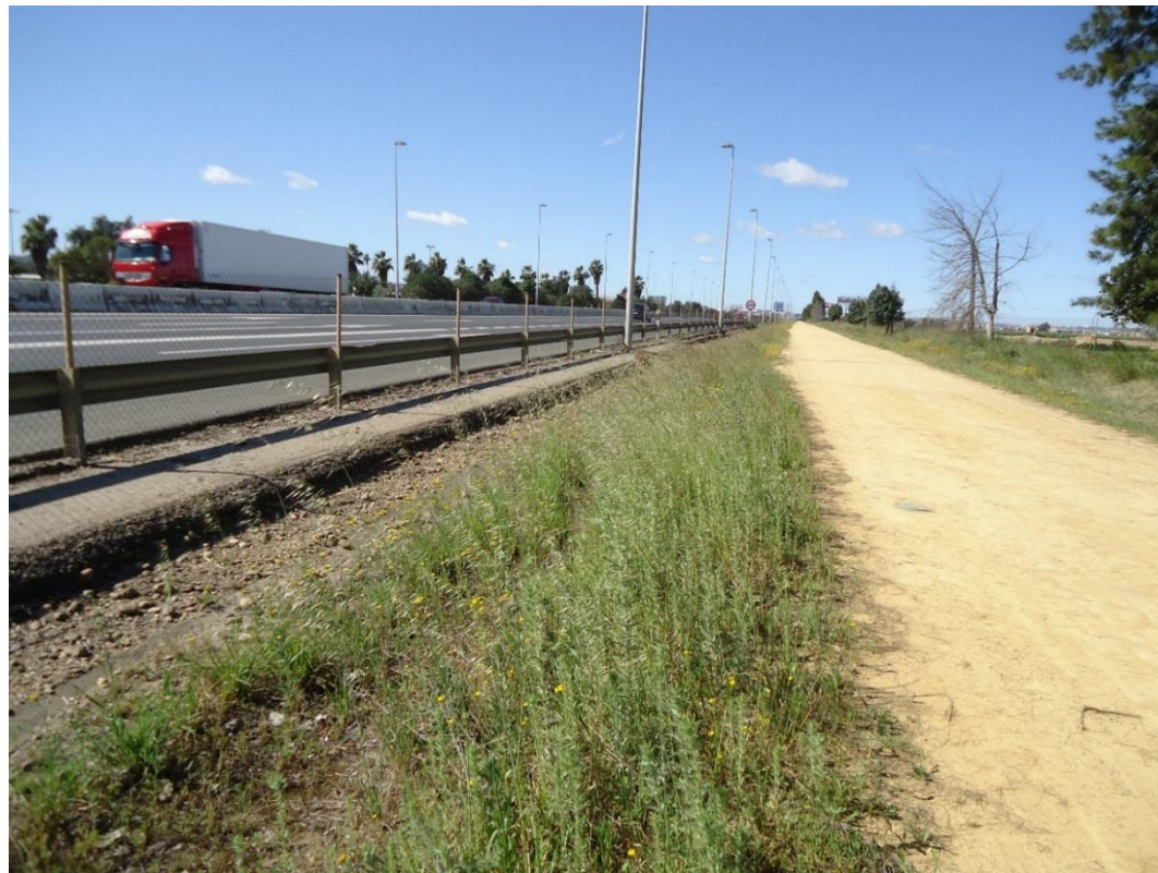
Situación actual camino paralelo A A4. Vista sentido Sevilla
