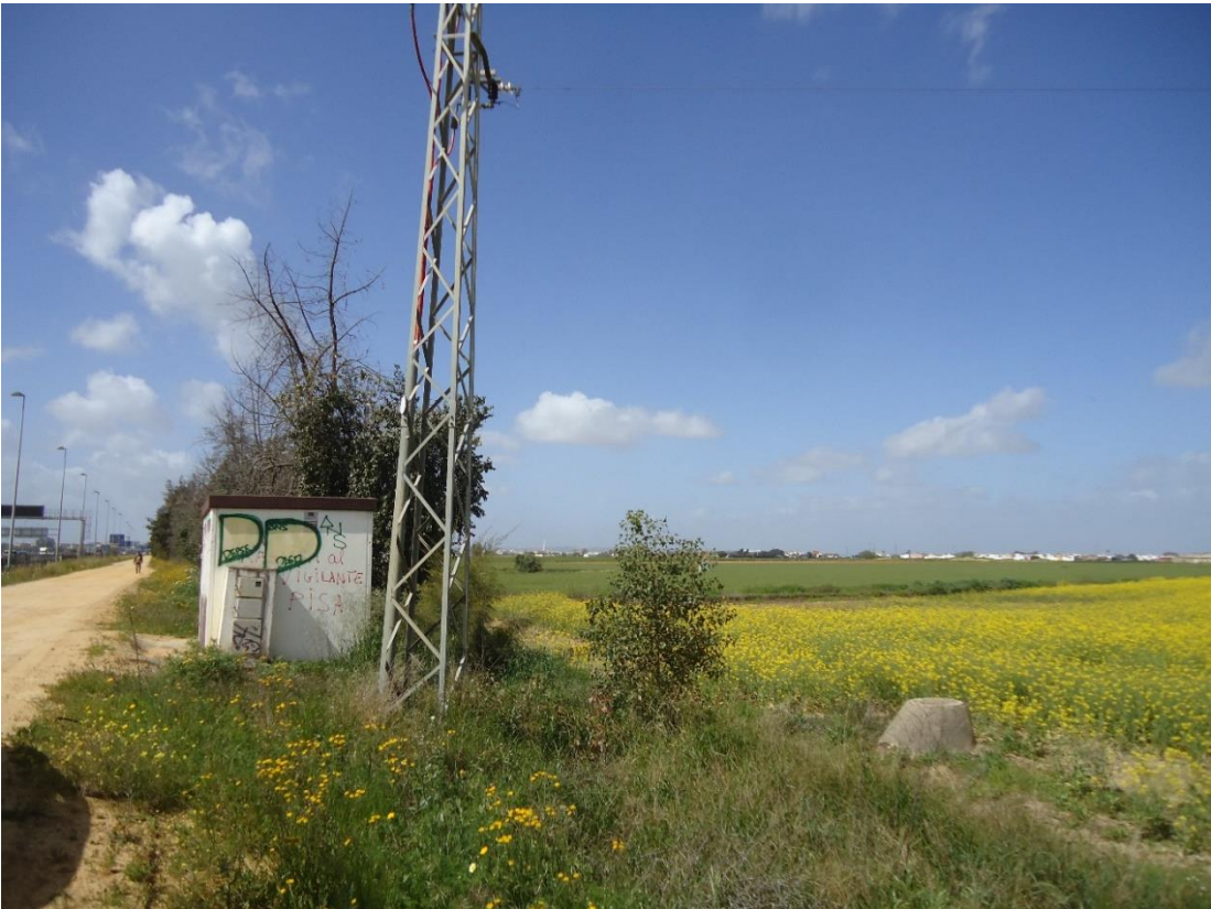
Ubicación de pozos en margen derecha del camino existente. Vista sentido Sevilla
