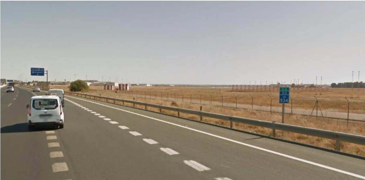
Figura 8 Vista del cerramiento común de la autovía y el aeropuerto de Sevilla
