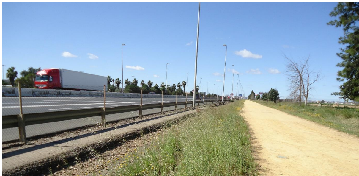
Figura 1 Vista de la posición actual del cerramiento
