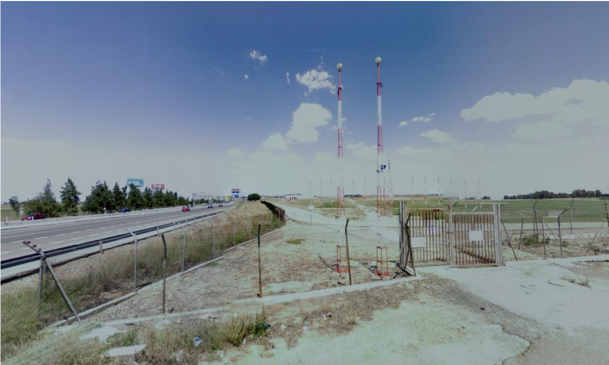
Figura 7 Vista del cerramiento y puerta existentes en el aeropuerto de Sevilla
