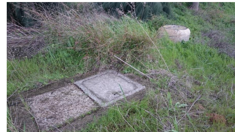
Pozo de registro margen derecha A-4 y arqueta registro fibra óptica.
