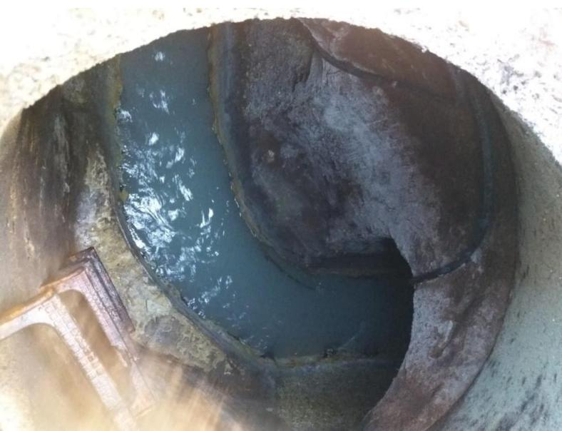
Interior pozo registro saneamiento. Conexión entre ovoide 1500/HAØ800 y fibra óptica.
