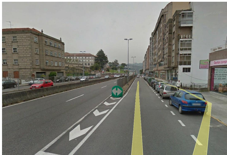
Imagen de Google Earth de uno de los hitos de vértice previo al comienzo de la vía de servicio en sentido creciente.
