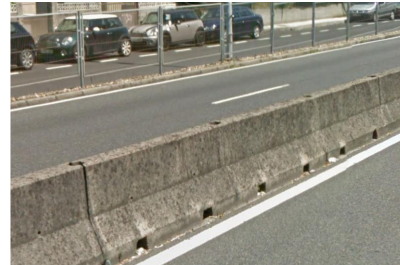
Imagen de Google Earth de la barrera de hormigón en la mediana de la avenida de Madrid.
