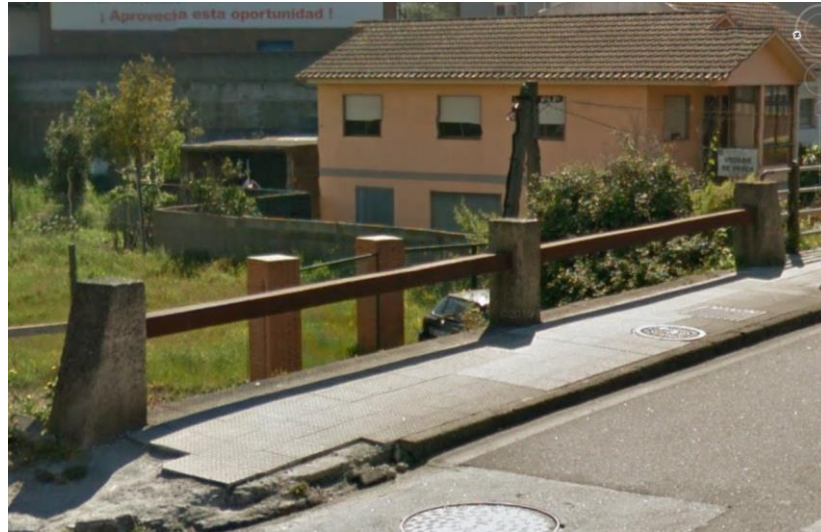
Imagen de Google Earth del pretil mixto en los extremos del paso inferior sobre el río Lagares.
