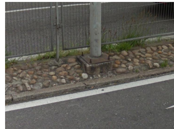
Imagen de Google Earth de la base de cimentación de uno de los báculos de alumbrado en una de las tercianas de la avenida de Madrid.
