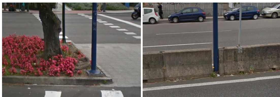
Imágenes de Google Earth de la base de cimentación de dos de los báculos de alumbrado en la mediana de la avenida de Madrid.
