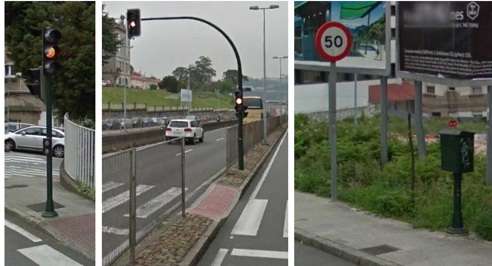
Imágenes de Google Earth de algunos de los elementos verticales existentes a lo largo de la avenida de Madrid.
