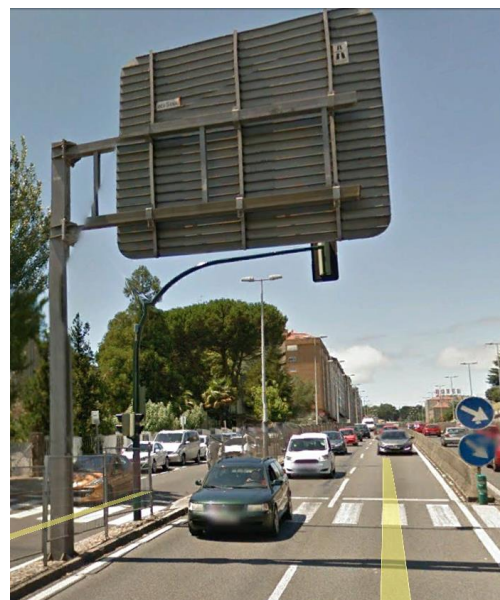
Imagen de Google Earth de la banderola de señalización existente en la tercia de la calzada creciente de la avenida de Madrid.
