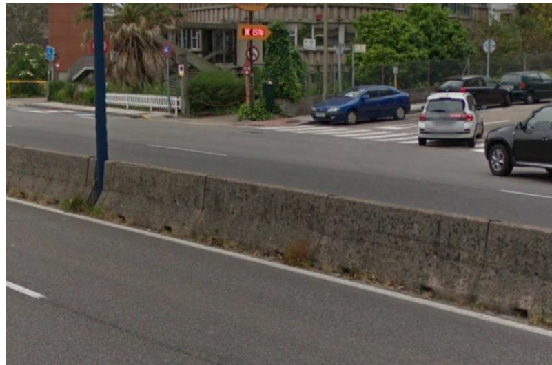
Imagen de Google Earth de la franja de firme en mediana que deberá ser demolida.
