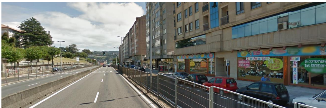
Vista Tramo 2 (Fuente Google Earth)
