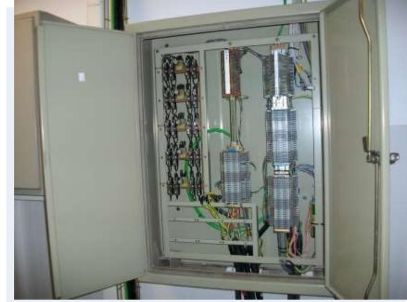
**Ilustración 5: Repartidor de Cobre**
