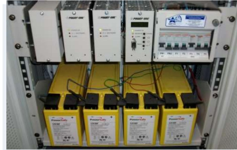
Ilustración 8: Sistema de Alimentación Ininterrumpida
