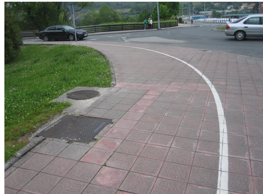
Intersección con carretera Snlace. Desde lado oeste
