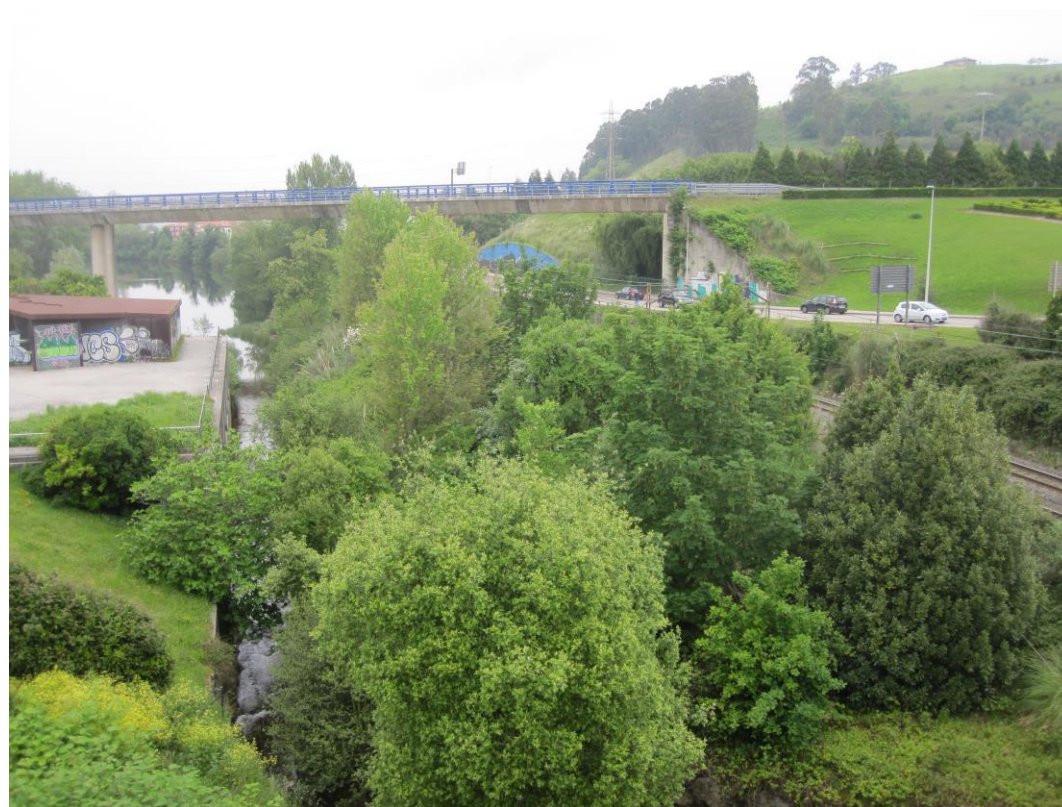
Zona de emplazamiento de estructura sobre encauzamiento previo al aliviadero de Sorravides
