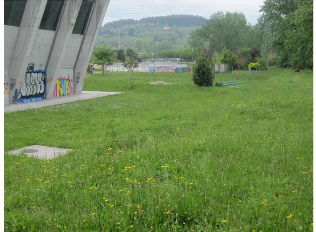
Zona de paso tras pabellón deportivo
