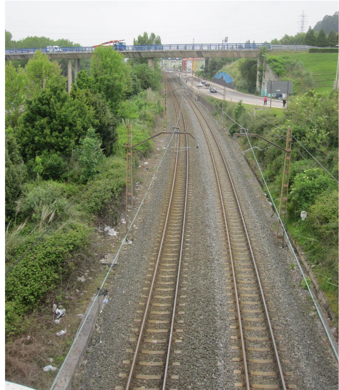
Zona de conexión de variante provisional con la línea existente en lado Santander
