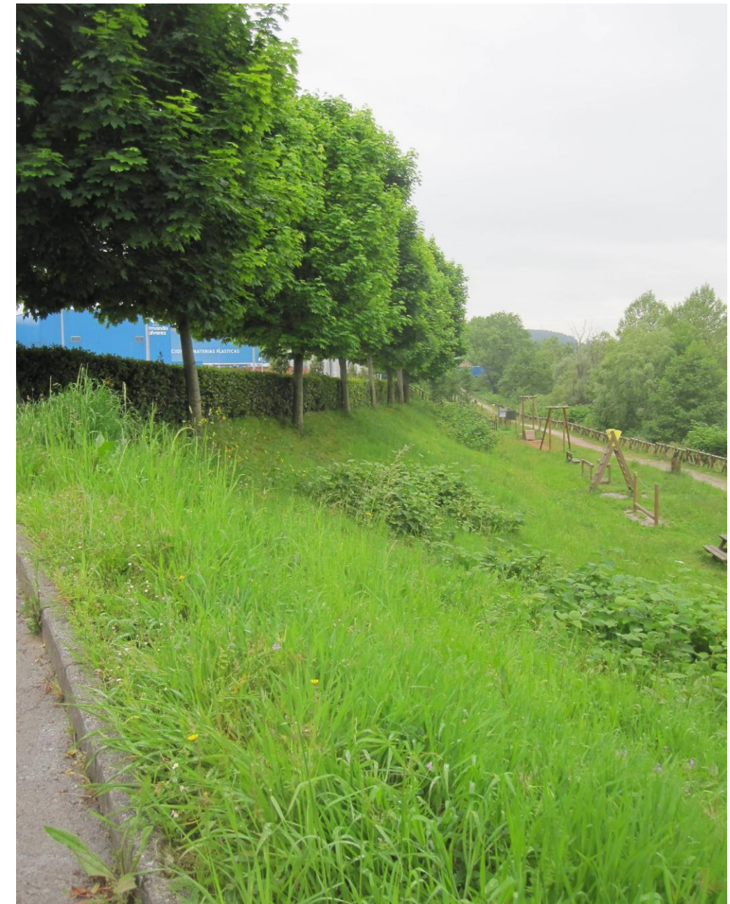
Tramo de desmonte hacia estructura sobre encauzamiento. Dirección oeste
