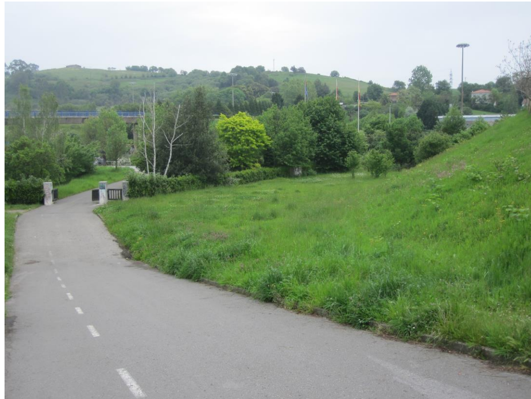
Tramo de desmonte hacia estructura sobre encauzamiento. Dirección este
