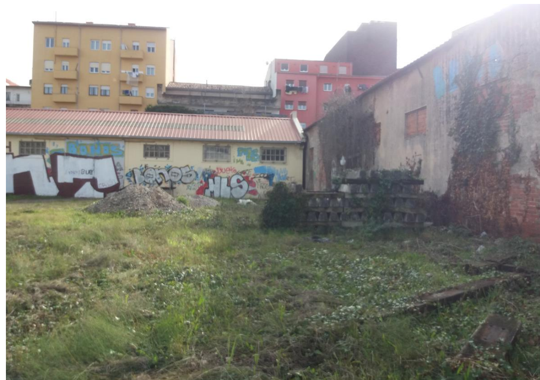
ZIA-2. Naves a demoler
