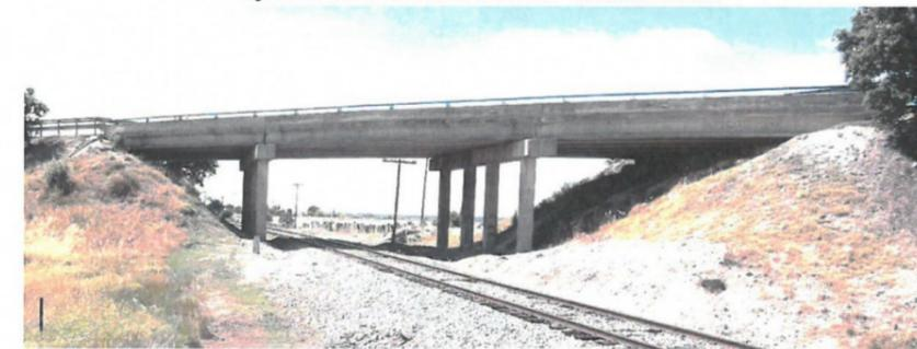
Los datos obtenidos del actual cruce con la línea de F.C. se muestran en los croquis de las Figuras 4 y 5, cuya rasante de referencia corresponde a la de la vía. Con las distancias obtenidas se obtuvo un gálibo vertical aproximado de 5,50m, siendo superior al especificado por la norma 506 UIC "Implantación de obstáculos" de 4,80 m.
