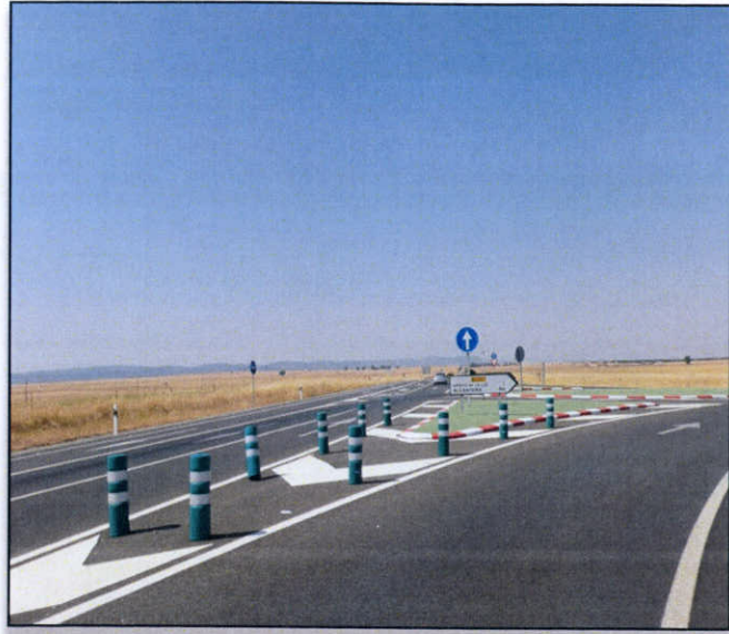
FOTO 22. Actual intersección entre la N-521 y la EX207
