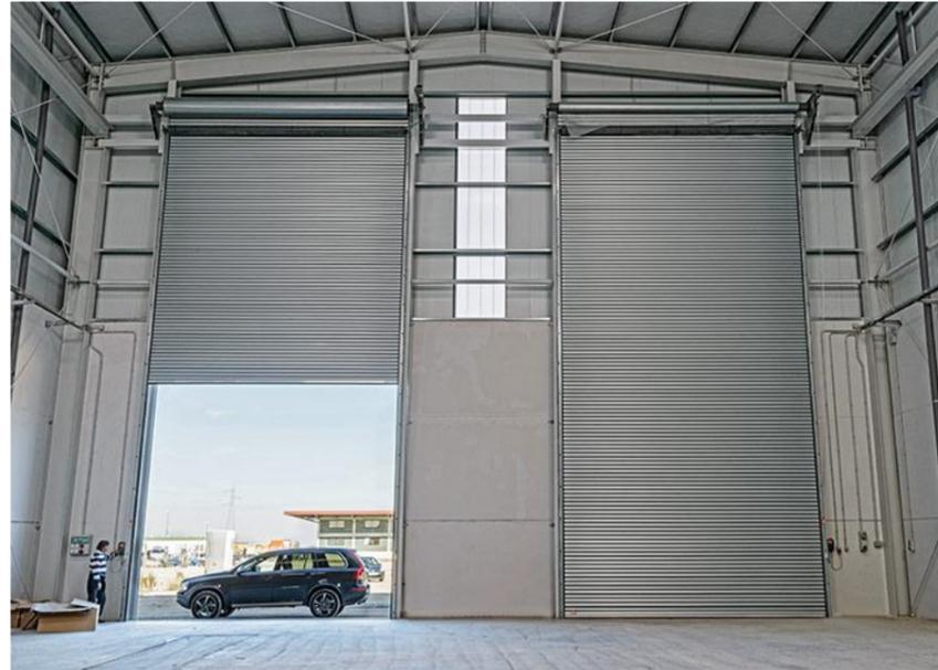
Ilustración 16 Ejemplo de puerta metálica enrollable motorizada. Fuente: INECO.
