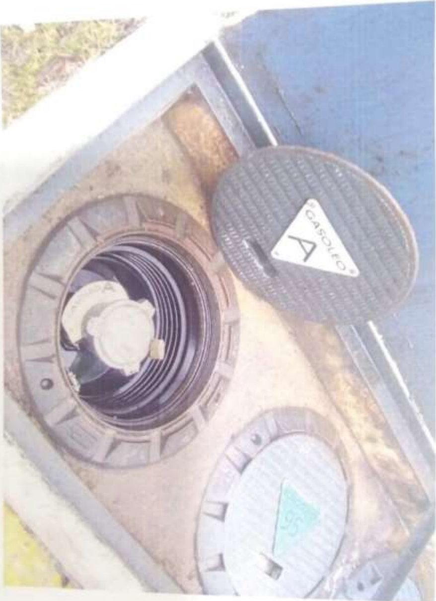
Foto nº 5. Detalle de boca de carga.
