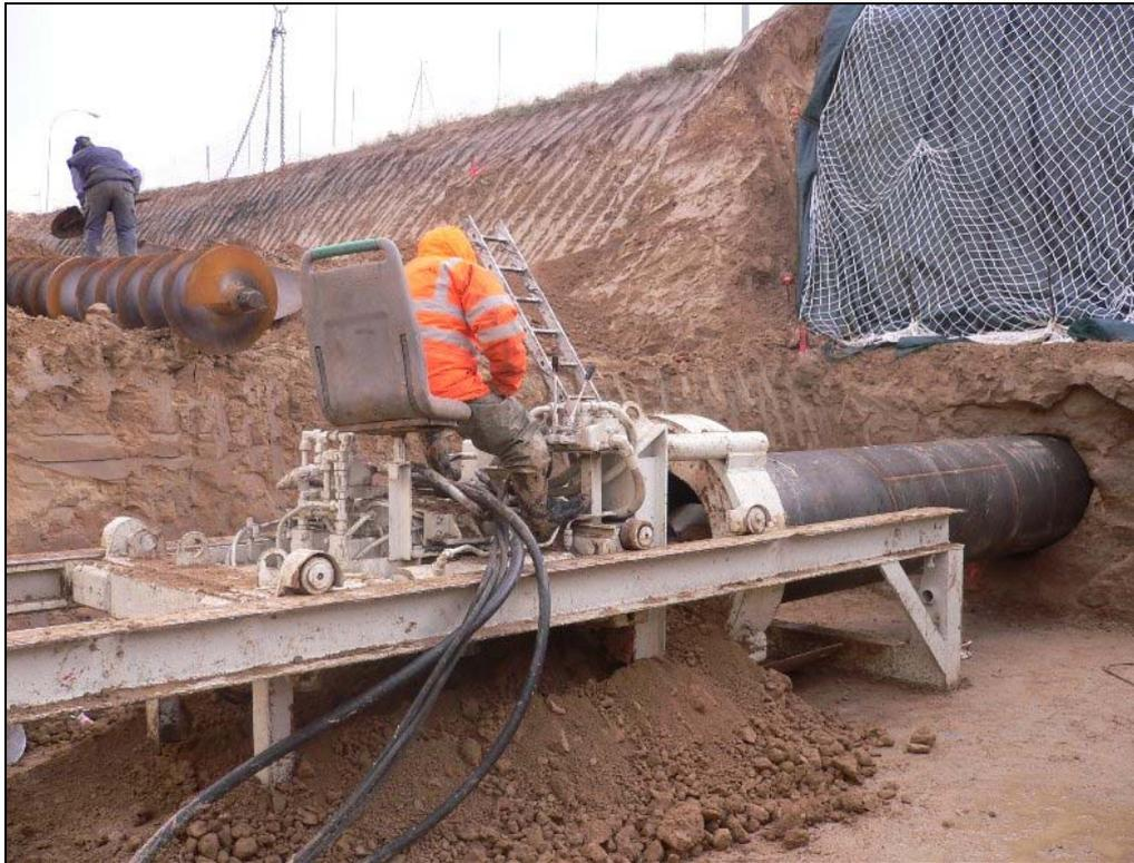
*Detalle de las correderas y cabeza de perforación, perforando en suelo (arcilla)*
