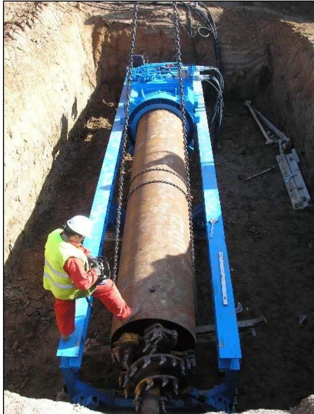
*Perforadora para tubo de revestimiento de gran diámetro*
