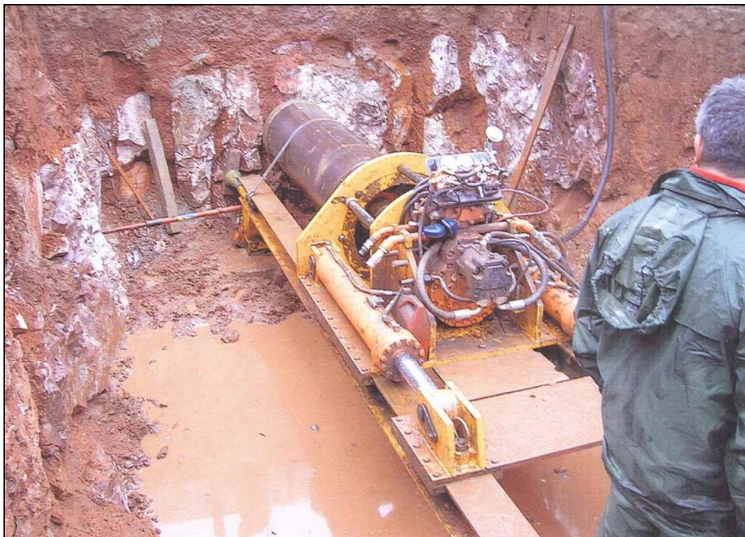
*Detalle de las correderas y cabeza de perforación, perforando en roca (caliza karstificada)*
