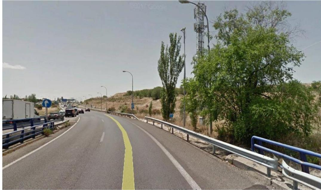
Se aprecia en la foto que existen dos carriles, arcén de 1,5m y barrera metálica. El eje 3 terminaría adosándose por la derecha a este ramal. Habría que preparar un acceso para la maquinaria de obra desde aquí, lo que implicaría desmontar la bionda, afectando al alumbrado y a la torreta de media tensión.
