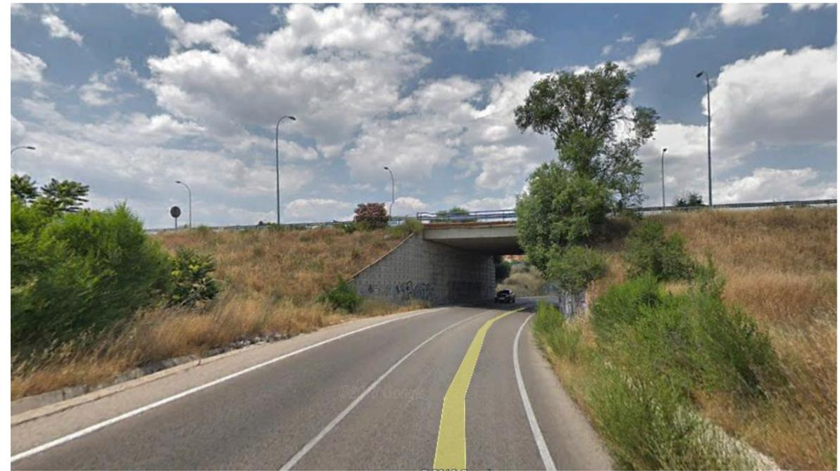
Aquí se recrecen ambos estribos y se ensancha el tablero de la M-21. El arcén es de 1,5 m. Debido a los medios de transporte y elevación que se requerirán, el arcén quedaría interrumpido y los carriles se estrecharían. Las operaciones se repetirían en el otro estribo.
