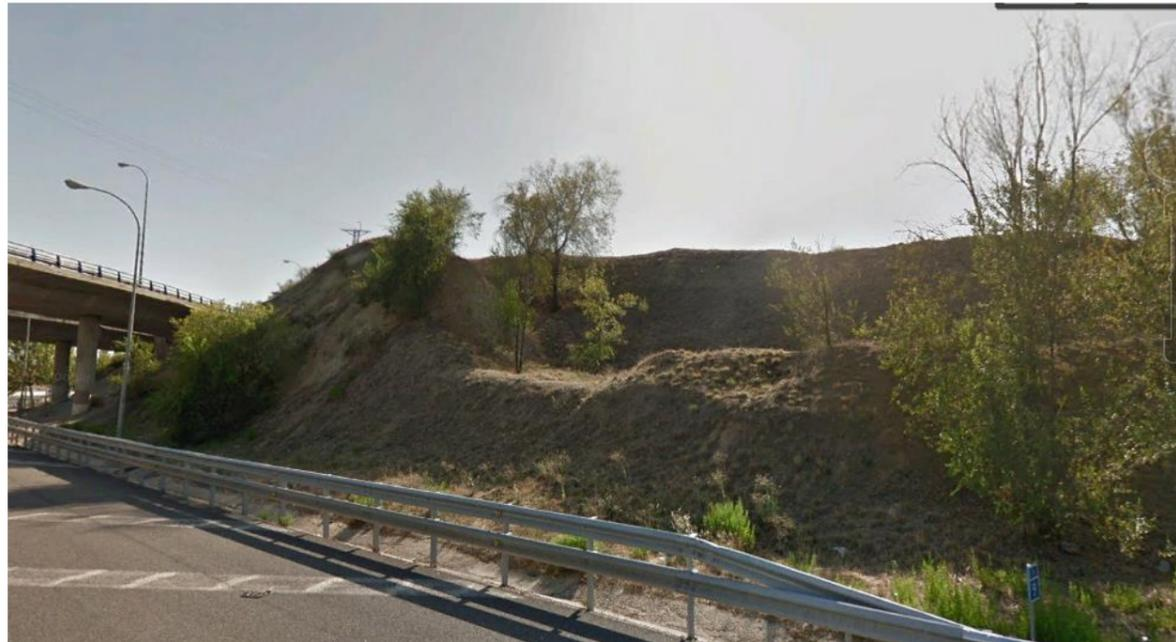
Para ejecutar el acceso a la maquinaria de obra habría que desmontar la bionda y la línea de iluminación. Dada la diferencia de cotas entre el pie del estribo y la base de la pila (unos 12-14 metros) es previsible un movimiento de tierras significativo, con lo que habrá que suponer un movimiento continuo de volquetes.
