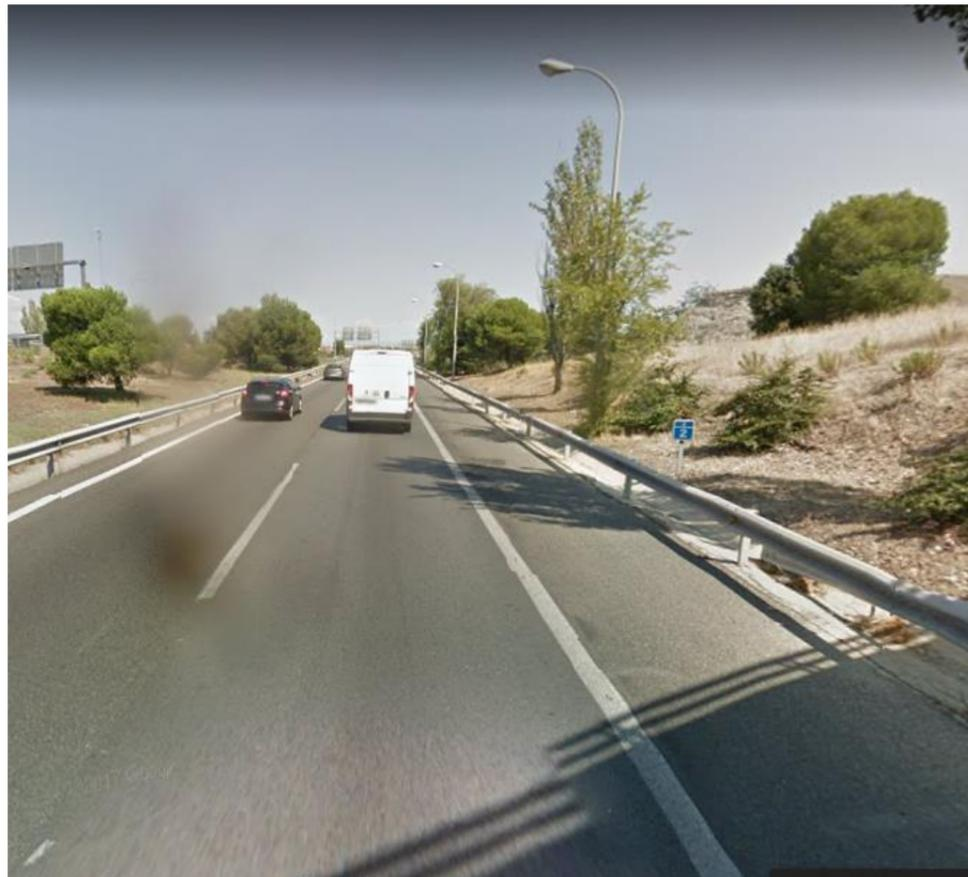
El ramal mostrado permite el acceso de la M-40 sentido norte a la M-14. Consta de dos carriles y arcén derecho de 1,5m. Hay a ambos lados biondas y cunetas triangulares revestidas. No existen farolas u otros elementos que entorpezcan la ejecución del estribo.
